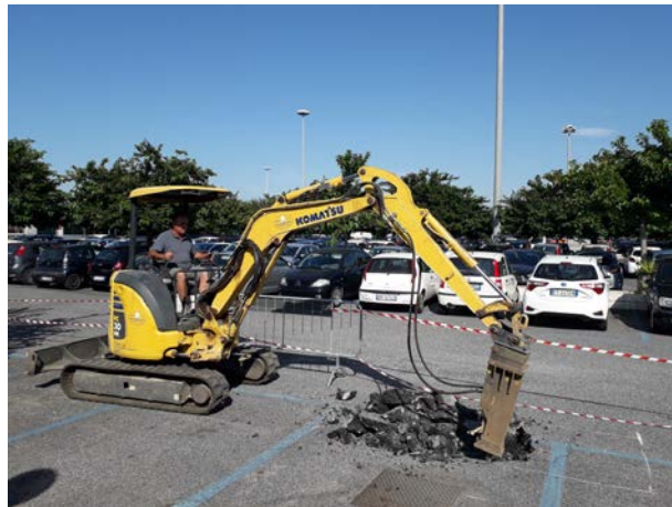
Preparazione del pozzetto – Rimozione dello strato di asfalto
